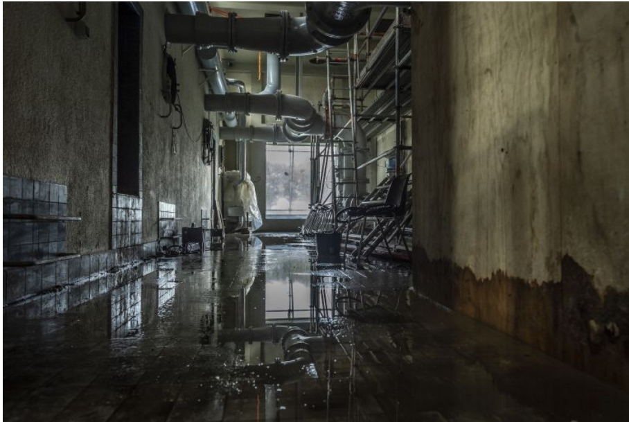
Renovatie De Groeve
