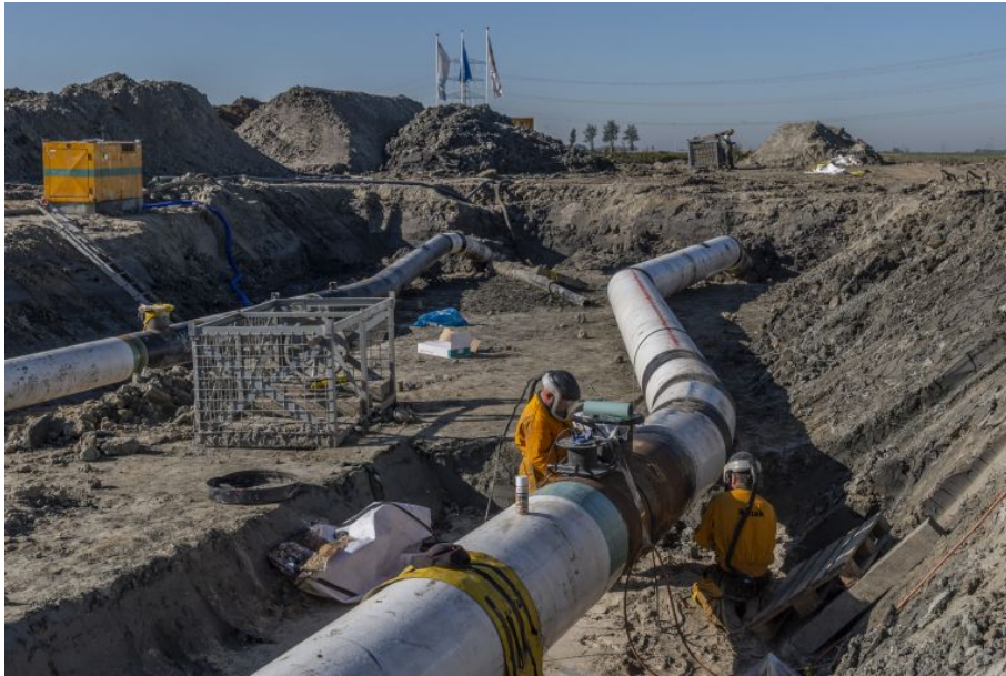
Werzaamheden ten behoeve van de duurzame watervoorziening
