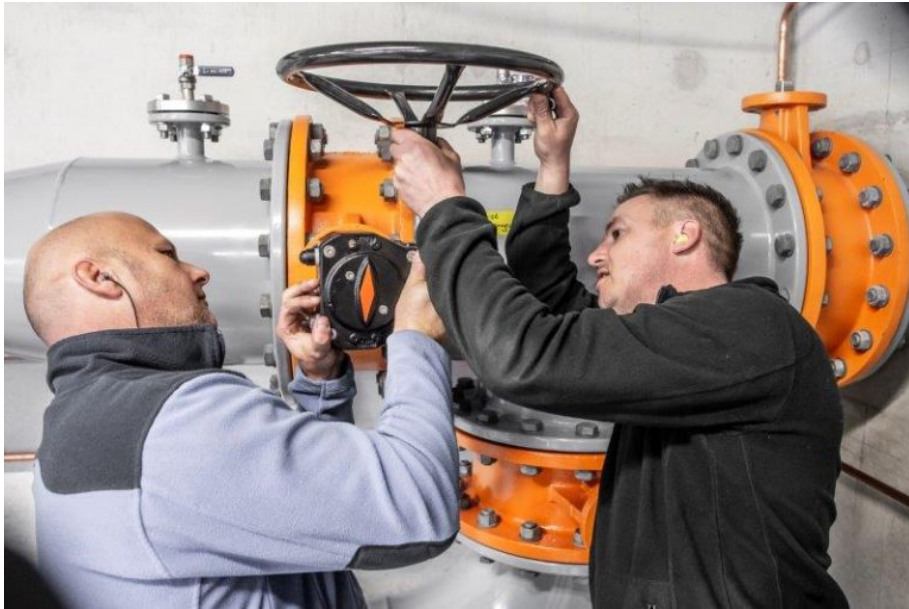
Fittingwerk DPS Appingedam
