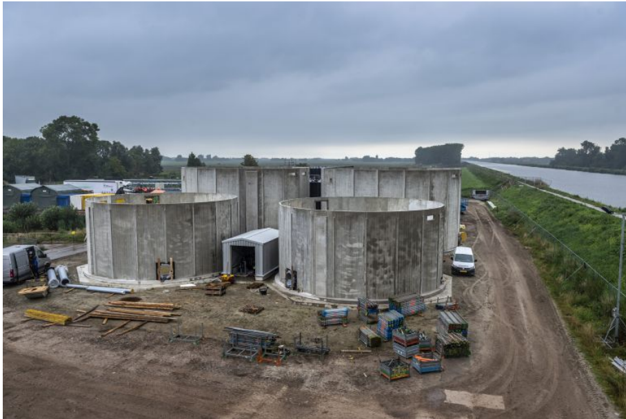
Nieuwe industriewatervoorziening in aanbouw op RWZI-terrein Garmerwolde
